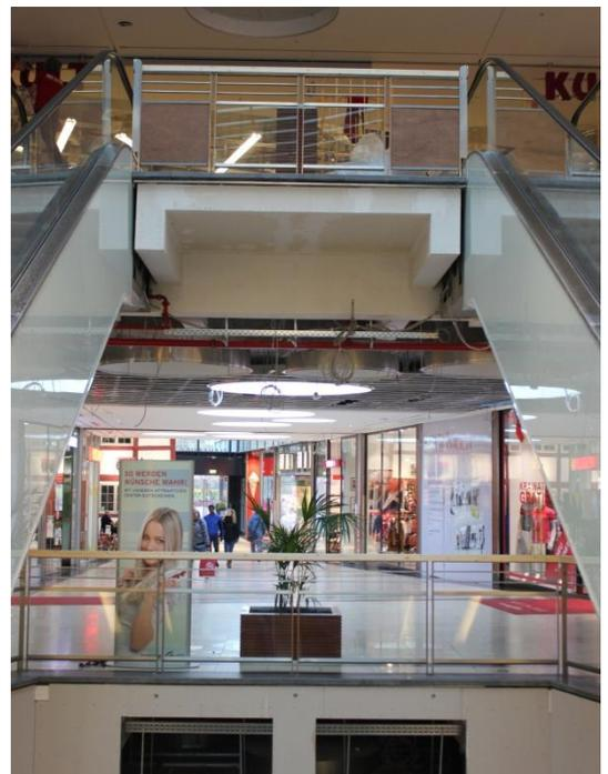
Wie schon bei dem Artikel über die Figuration der Lichthöfe beschrieben, müssen die Seiten der Lichthöfe mit Gipskarton geschlossen werden. Aufgrund der Höhe und der schweren Erreichbarkeit sind Gerüste notwendig und unvermeidbar.
